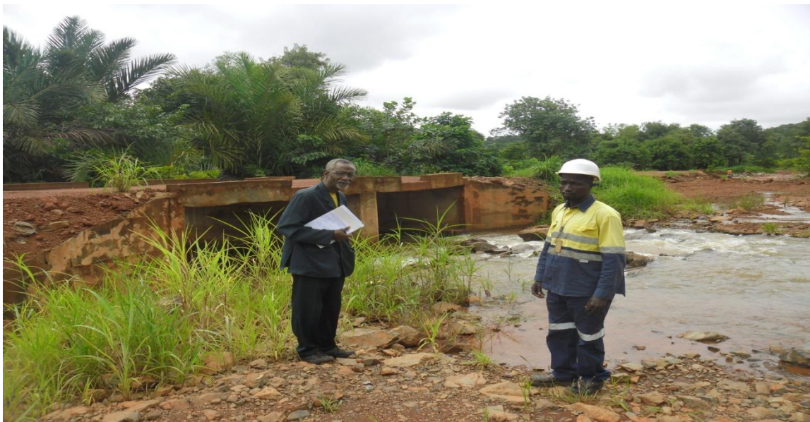
Pont sur cours d'eau Sirifé en Direction de Siguirini (financement de la SMD)
