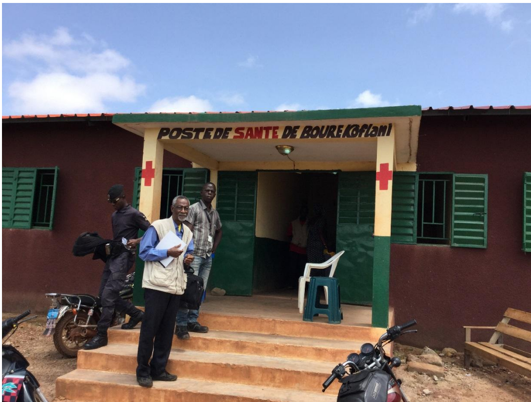
Entrée du Poste de Santé de Bouré financé par la SAG
