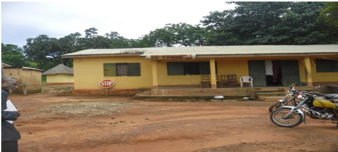
Bâtiment administratif à Siguirini (Financement CDL SMD)
