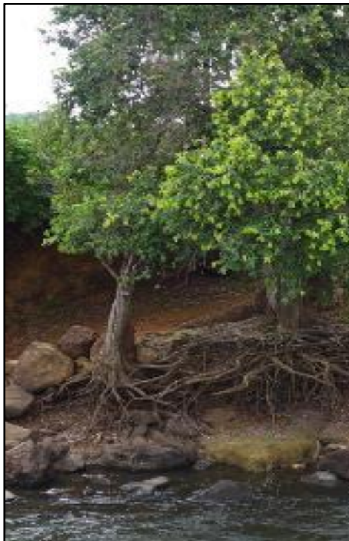
Figure 54: Déchaussement des arbres à l'aval immédiat du seuil de la prise d'eau sur le Kogon à la CBG à Sangarédi
