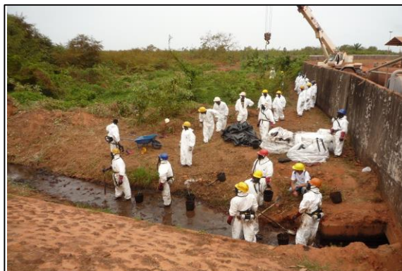
Figure 51: Pollution aux hydrocarbures à Kamsar
