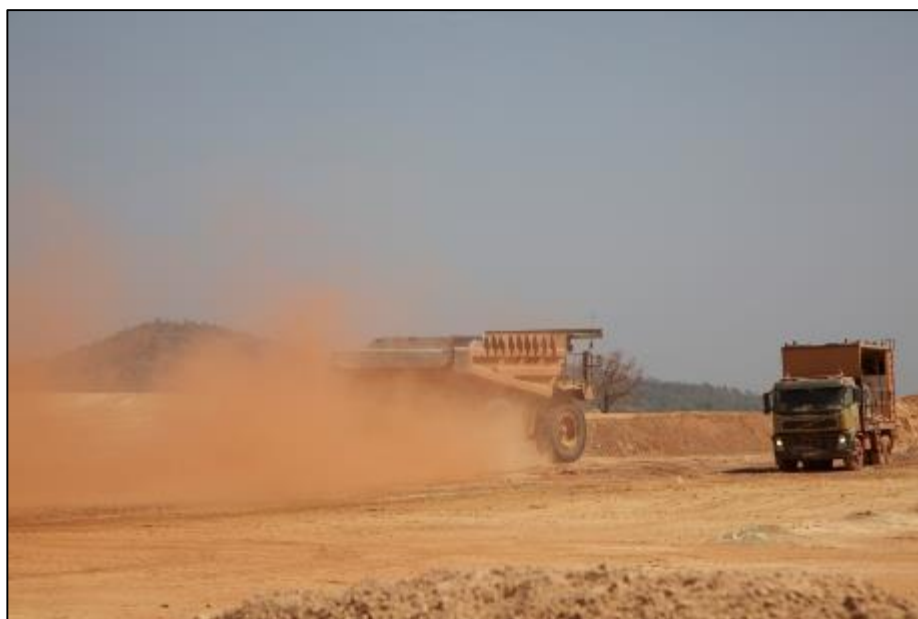
Figure 59 : Poussière générée par l'activité du secteur industriel. Photo S.BOUJU
