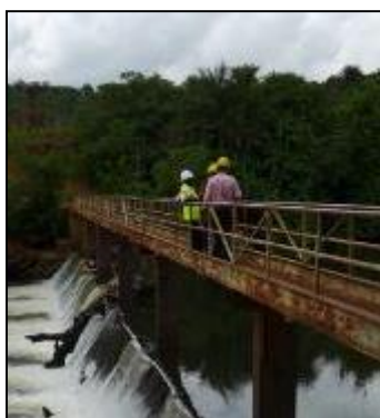
Figure 40: Seuil de la prise d'eau sur le Kongon à Sangaredi
