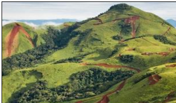
Figure 43: Figures d'érosion au sommet des monts Simandou associées aux pistes et plate formes de forage en phase de développement
